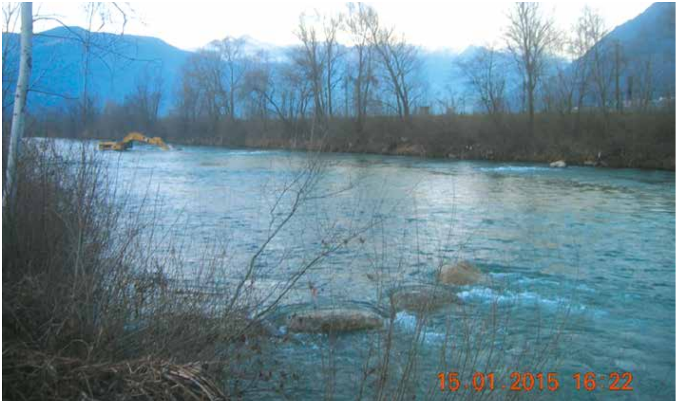
Bagger in der Etsch bei Terlan beim Bau der „Schaubergerbühnen“, die bananenförmig leicht gegen die Fließrichtung gekrümmt sind
