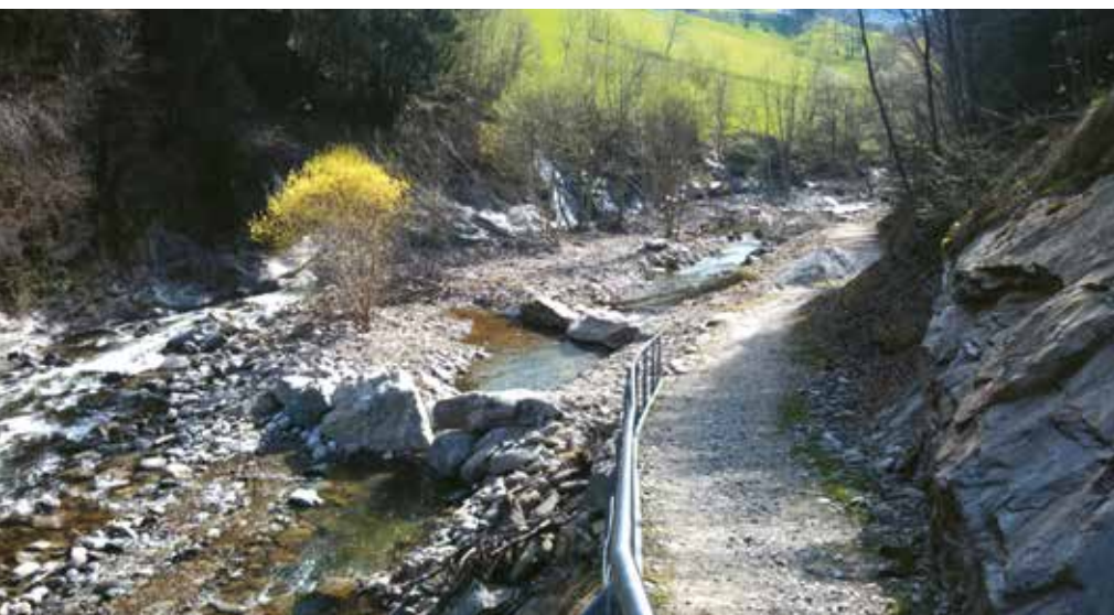
Einlaufbereich des neu geschaffenen Seitengewässers an der Passer oberhalb Gomion. Mit Schlitzsperrn aus Zyklosteinen im Einlaufbereich soll die Wasserführung und vor allem die Geschiebemenge im neuen Seitenbachl begrenzt werden.
