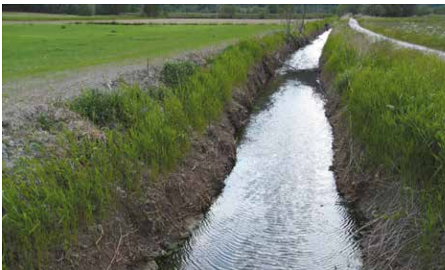
Südtiroler Graben ohne Uferschutz – dadurch können Schadstoffe aus dem Umland ungehindert eindringen (Foto: Roland Borghi).
