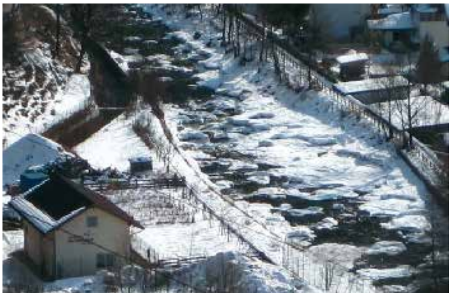
Ausleitungsstrecke eines bestehenden Kraftwerkes in Sand in Taufers, unterhalb der Daimerbrücke: ist ein Restwasser überhaupt noch erkennbar? Bei Realisierung der Ahrstufe 6 wird die Ahr von Luttach bis Bad Winkel dieses Aussehen haben.
