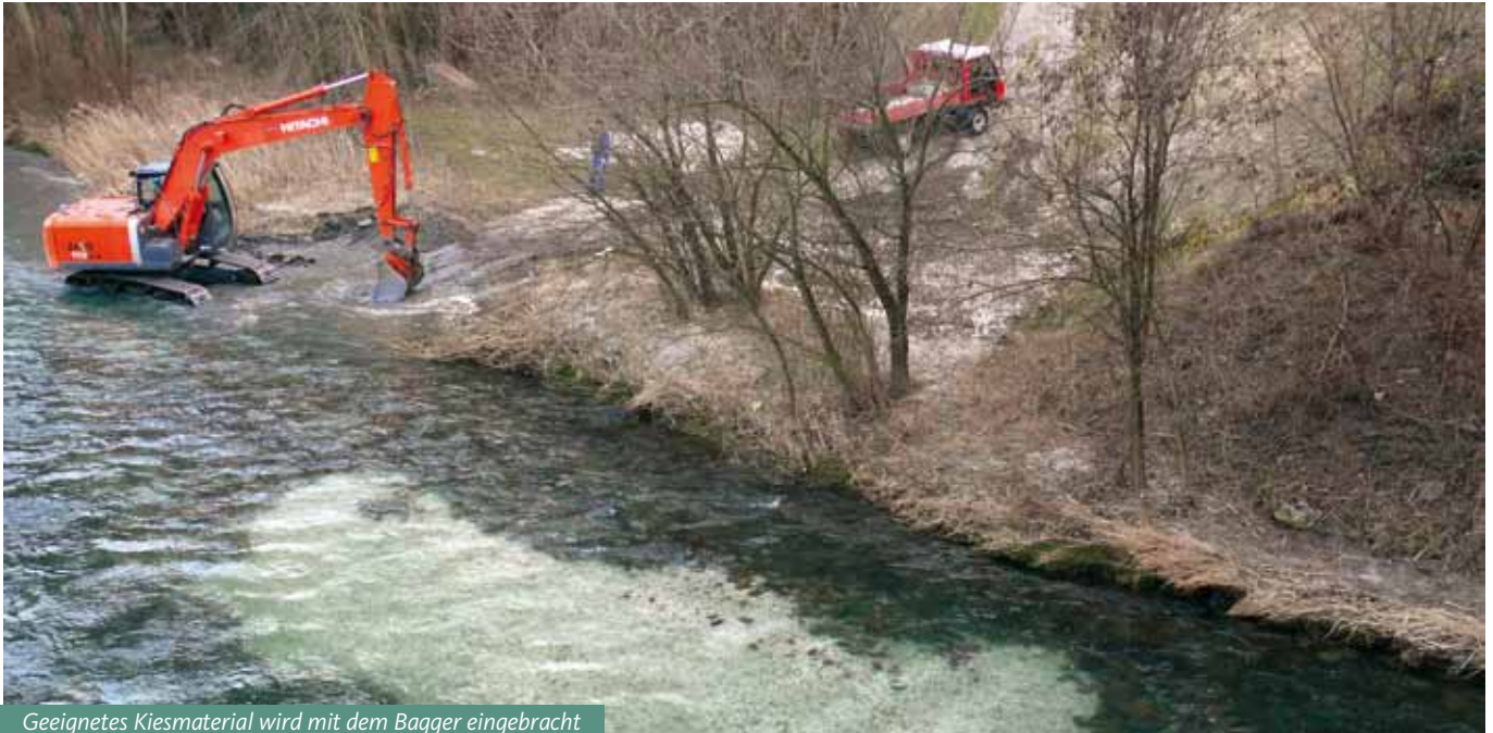
Geeignetes Kiesmaterial wird mit dem Bagger eingebracht
