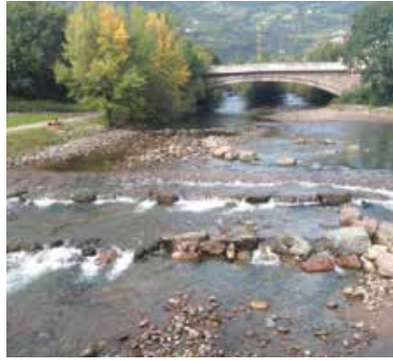
Sohlschwelle bei der Talfermündung (mit Schwallwasserstand) 2013 und nach der Umgestaltung 2015 (mit Sunkwasserstand)
