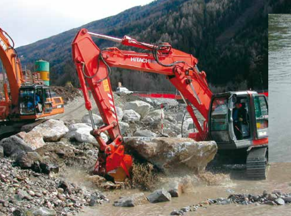
Die Anlegung mancher Zyklopensteine war keine einfache Aufgabe...
