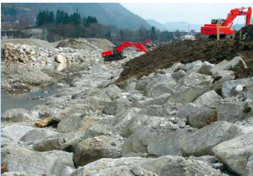
Errichtung der verhältnismäßig flachen Böschung des linken Ufers (rechts im Bild)
