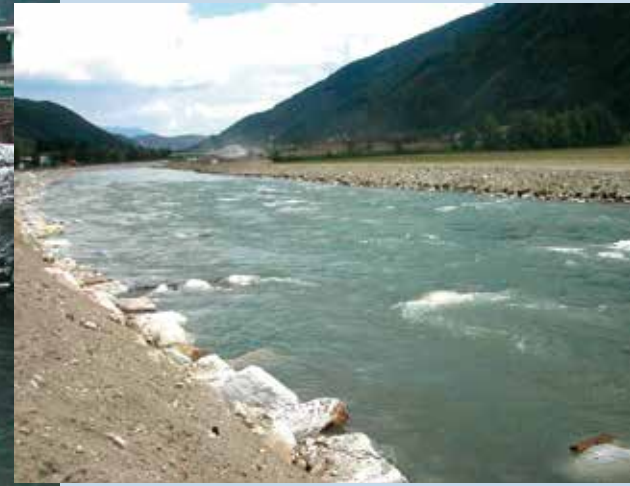
Der zentrale Bereich der betroffenen Rienzstrecke unmittelbar nach der Verlegung (Aufnahme flussaufwärts): Breitere Sohle, deutliche Wirkung der Buhnen und der gruppierten Stör- und Ansatzsteine
