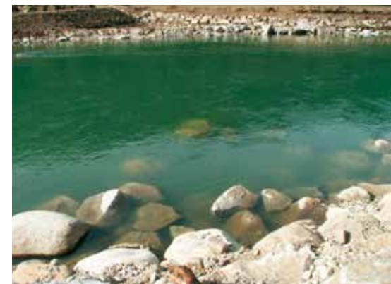
Reichlich strukturierter Böschungsfuß am rechten Ufer; im Hintergrund die Einkerbung des linken Ufers bei der Mündung des Kaserbaches.
