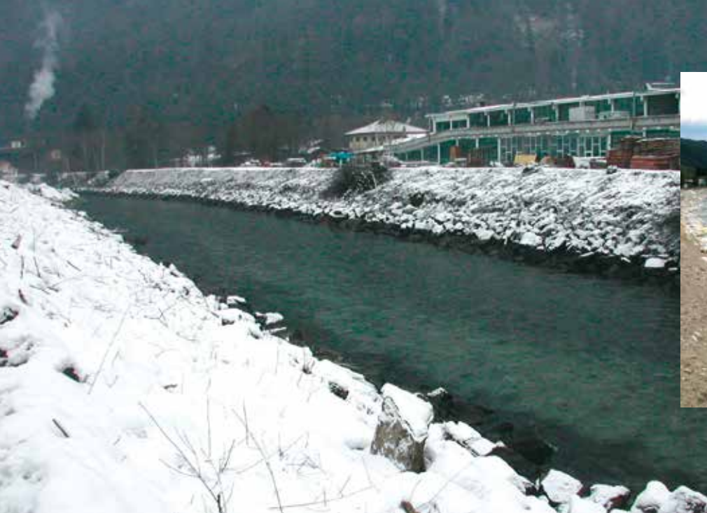
Die strukturarme Rienzstrecke vor der Verlegung (Streckenmitte; Aufnahme flussabwärts)
