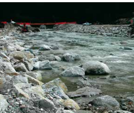
Gruppierte Ansatzsteine am rechten Ufer (links im Bild)
