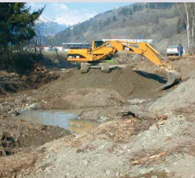
Aushubarbeiten zur Revitalisierung des Altarmes Mareiter Bach
