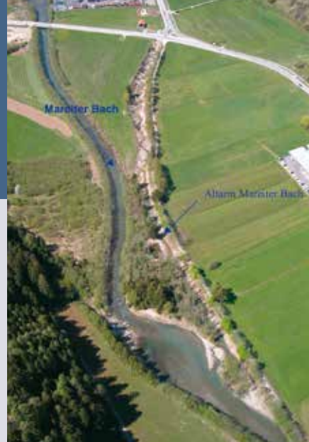
Luftbild des revitalisierten Mareiter Baches kurz nach Abschluss der Arbeiten Mitte April
