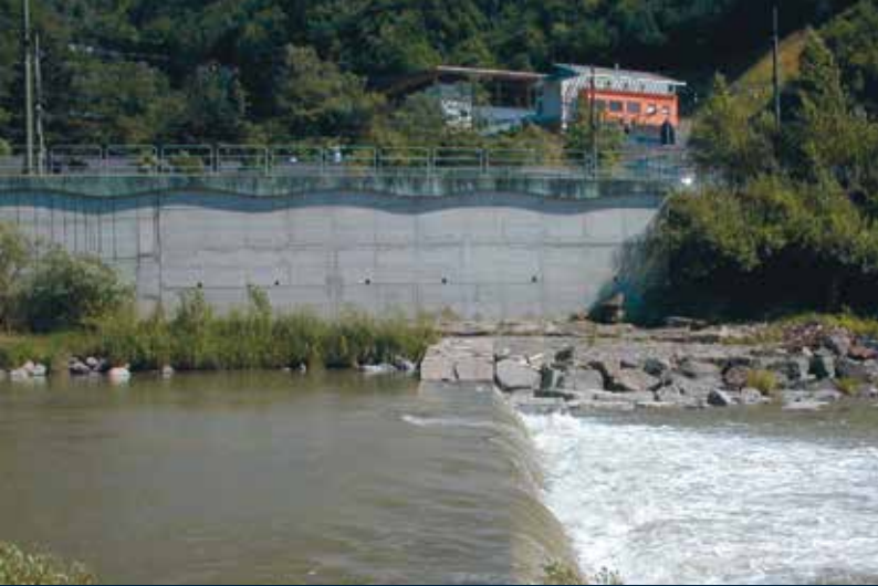
Untere Sperre in Blumau vor dem Rückbau
