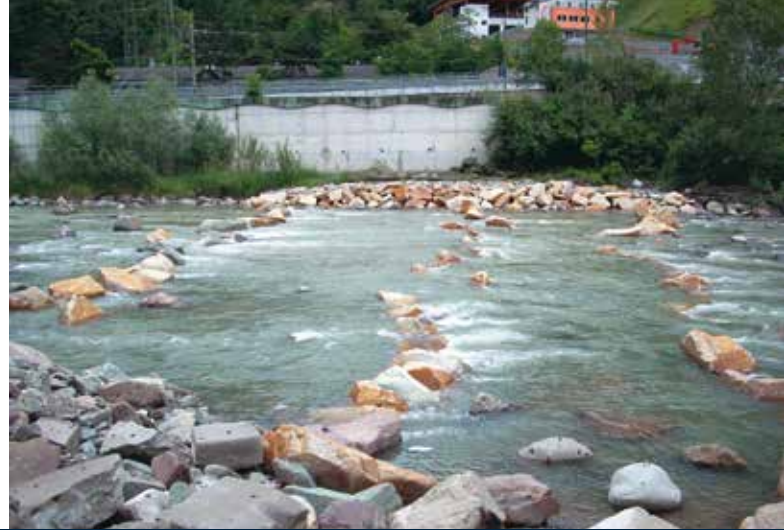
Aufgelöste Rampe anstelle der ehemaligen unteren Sperre in Blumau (Foto V. Adami)
