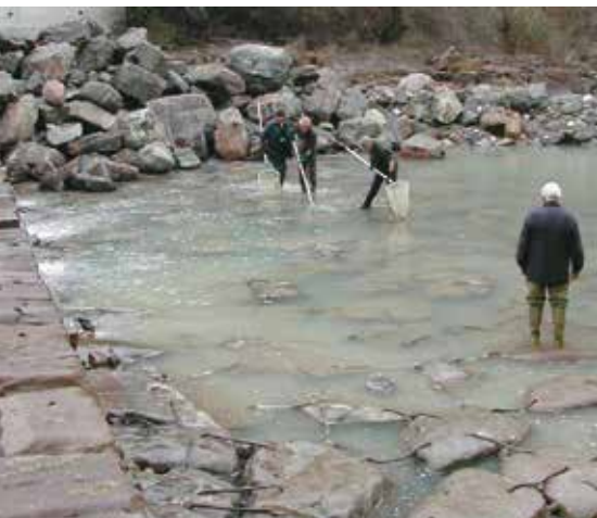
Die teilweise trocken gelegte untere Sperre mit der Sohlpflasterung im Unterwasser vor ihrem Abbau. Vor der Ausbaggerung wurde die Strecke elektrisch abgefischt (Foto V. Adami)
