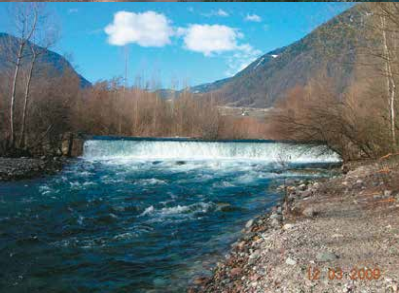
Konsolidierungssperre in der Falschauer, vor und nach der Umgestaltung in eine aufgelöste Rampe
