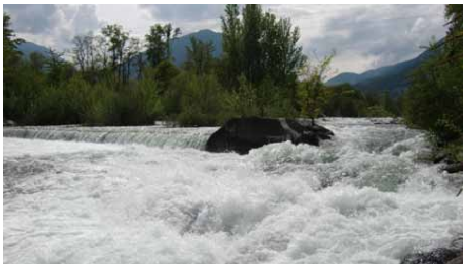
Dasselbe Sperrenbauwerk innerhalb weniger Minuten. Oben bei Sunk, unten bei Schwall.
