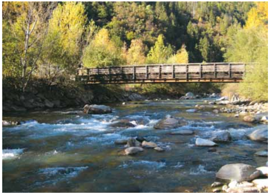
Örtlichkeit: Riffian – Lufer Brücke Abgefischte Länge: 115m
