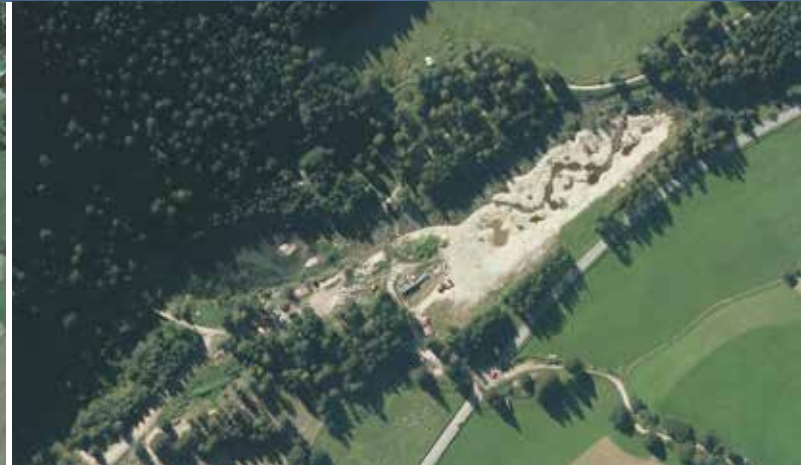
Falschauer oberhalb des Zögger Stausee 2014 nach Umsetzung des ersten Bauloses zur Revitalisierung
