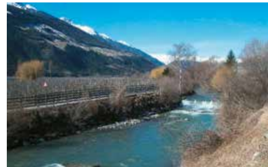
Vorher: Etsch bei Vetzan mit unüberwindbarer Sperre (2014)
