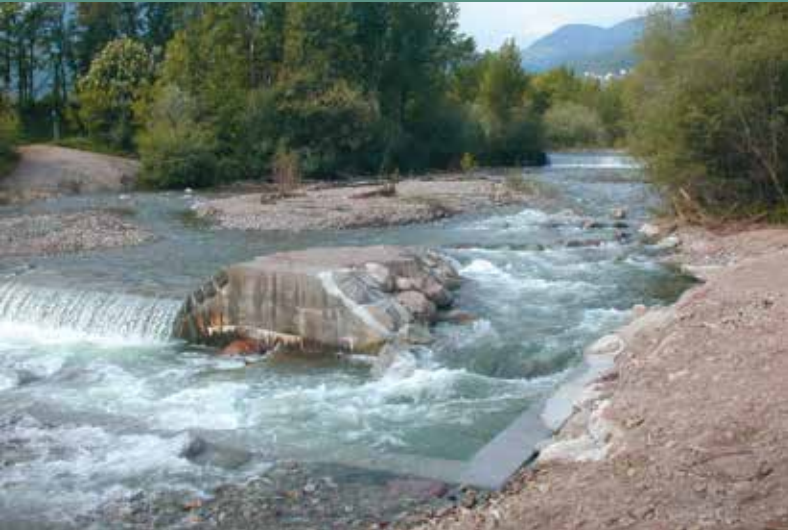
Fertiggestellte L-Rampe im Mai 2007 an der 5. Sperre der Falschauer
