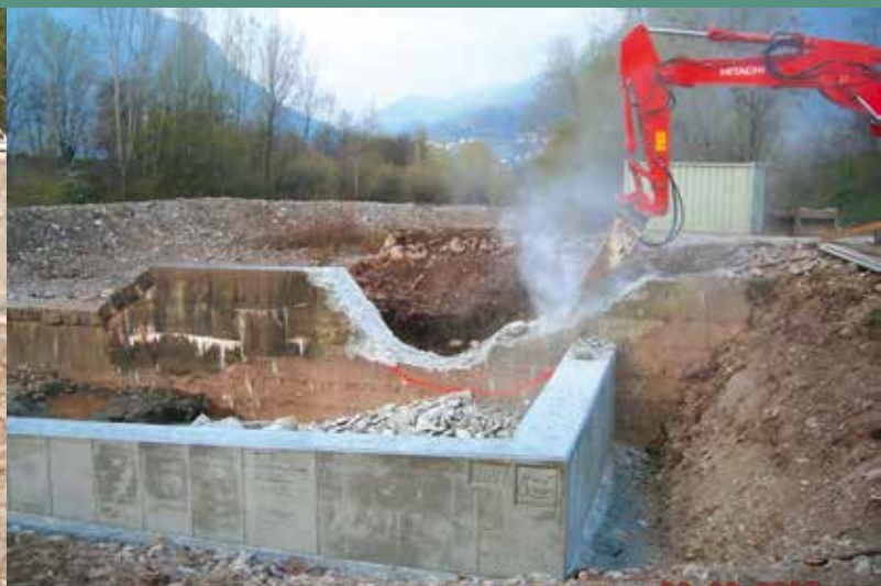
Abbruch der Sperrenschulter, um die Abflussection des Umgehungsgerinnes um 70 cm tiefer zu legen als Hauptsection der Sperre
