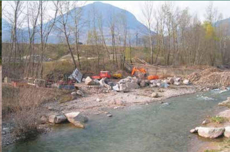
Die 4. Sperre der Falschauer am Beginn der Umgestaltungsarbeiten zur L-Rampe
