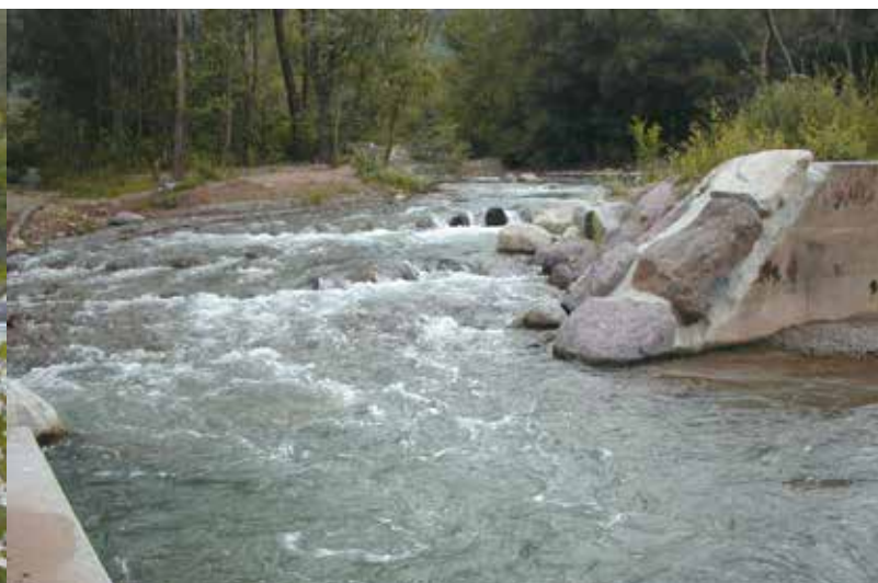
Einlaufbereich des Umgehungsgerinnes an der 4. Sperre der Falschauer im Sommer 2007
