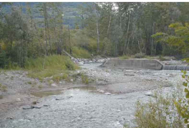
Fertiggestelltes Umgehungsgerinne mit „L-Rampe“ im Mai 2007 an der 4. Sperre
