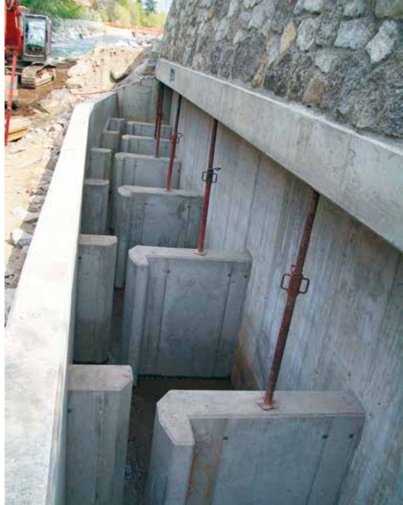
Der Schlitzpass kurz nach Fertigstellung der Betonarbeiten
