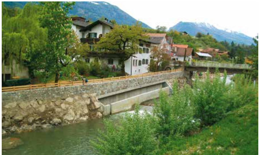
Die Etsch nach Abschluss der Arbeiten
