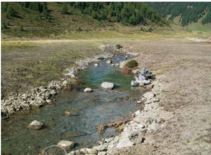
Das neue Bachbett des Schlandraunbaches wurde umsichtig in das Gelände eingefügt, das bereits während der Arbeiten das Bild eines „gewachsenen“ Baches entstand
