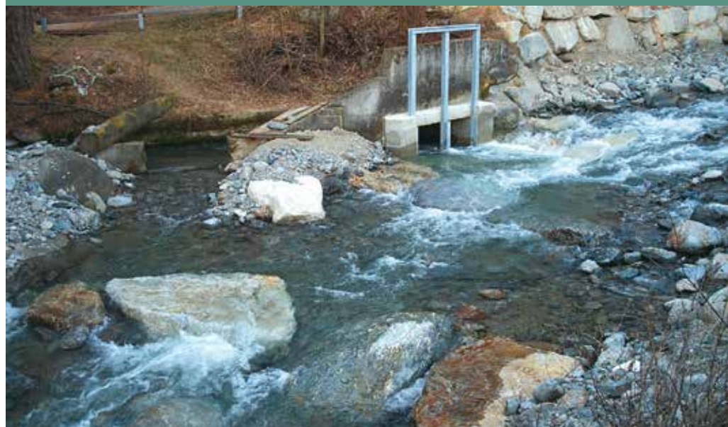
Die Etsch oberhalb Laatsch: das ehemalige Wanderungshindernis ist mit dem Umbau selbst für schwache Schwimmer wie die Mühlkoppe überwindbar
