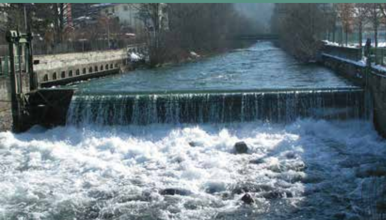
Ableitungsbauwerk zur Erzeugung hydroelektrischer Energie – ohne den Einbau einer Fischtreppe ist hier Endstation für wandernde Fische.
