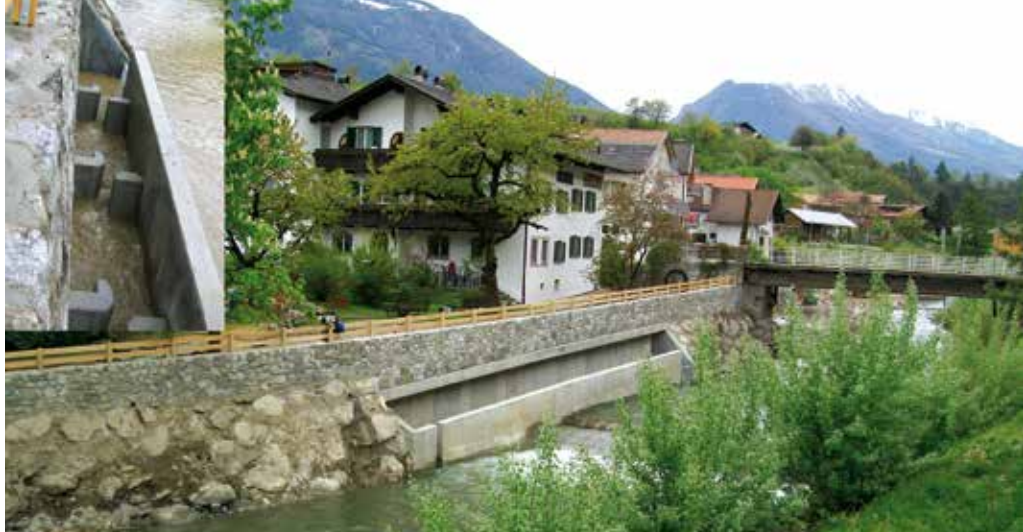
Der so genannte Vertical-Slot-Fischpass bei Kastbell, eine technische Fischaufstiegshilfe die selbst bei wechselnden Wasserständen im Oberwasserbereich funktioniert (Detailfoto: oben links) Die Beckenschlitze reichen bis an den Beckengrund und sind aufgrund der geringen Strömungsgeschwindigkeit auch für schwache Schwimmer überwindbar.
