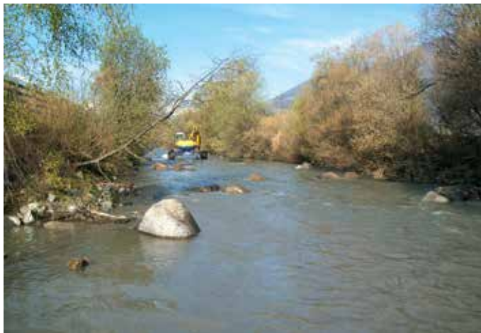
Schreitbagger bei der Verlegung von Störsteinen und Steinbuhnen in der Etsch Neu errichtete Niedrigwasserbuhne
