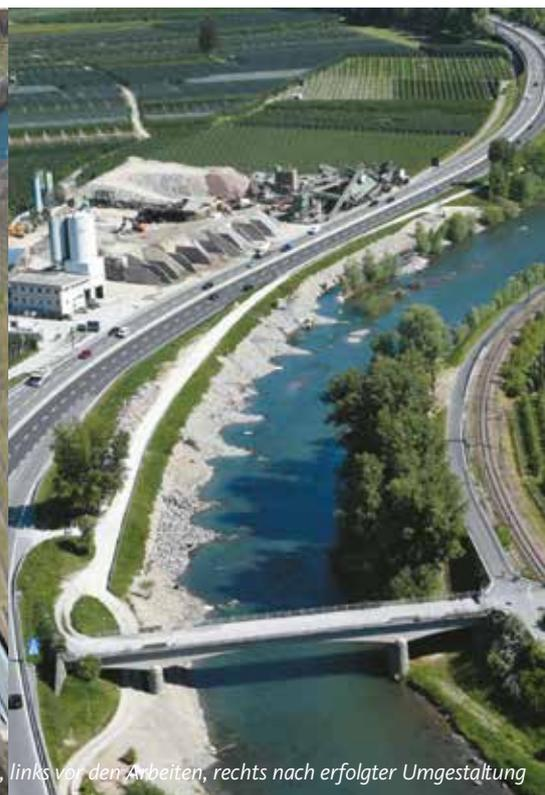
fahrt Lana auf einer Länge von 225 Metern ebenfalls eine Flussaufweitung verwirklicht. Ähnlich wie in Salurn sind das Flussbett verbreitert, die Ufer neu gestaltet und Strukturelemente für Fische eingebracht worden.
