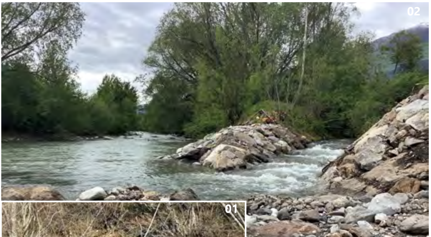
Mündung des Schlandraunbaches vor (01) und nach (02) der strukturellen Aufwertung. Nun ist die Mündung des Seitenzubringers der Etsch fischpassierbar.
