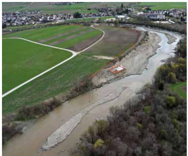
Foto 2: Ahr im Bereich im Sack bei St. Georgen, Situation während der Bauphase
