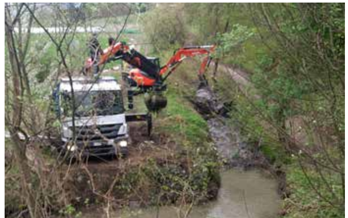
Beginn der Bauarbeiten zur Strukturierung des „Zipfergrabens“
