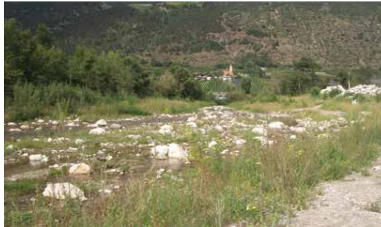
Bachbett der Plima auf Höhe Handwerkerzone Latsch. Situation vorher mit minimalen Wassertiefen, ohne erkennbaren Hauptstrom.
