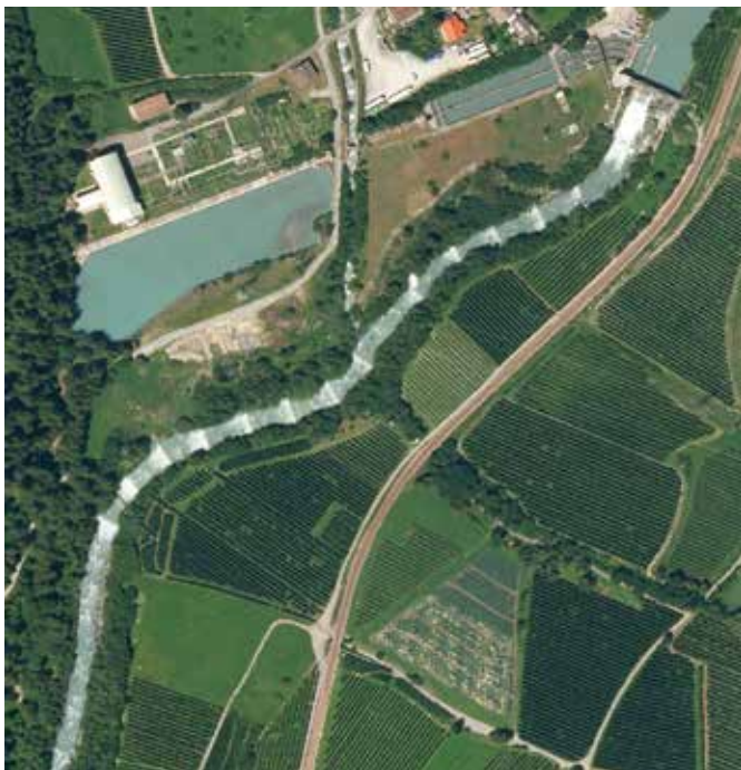
Vorher: 14 Sperrn und die Wasserfassung unterbrechen das Fließgewässerkontinuum der Etsch bei Laas.
